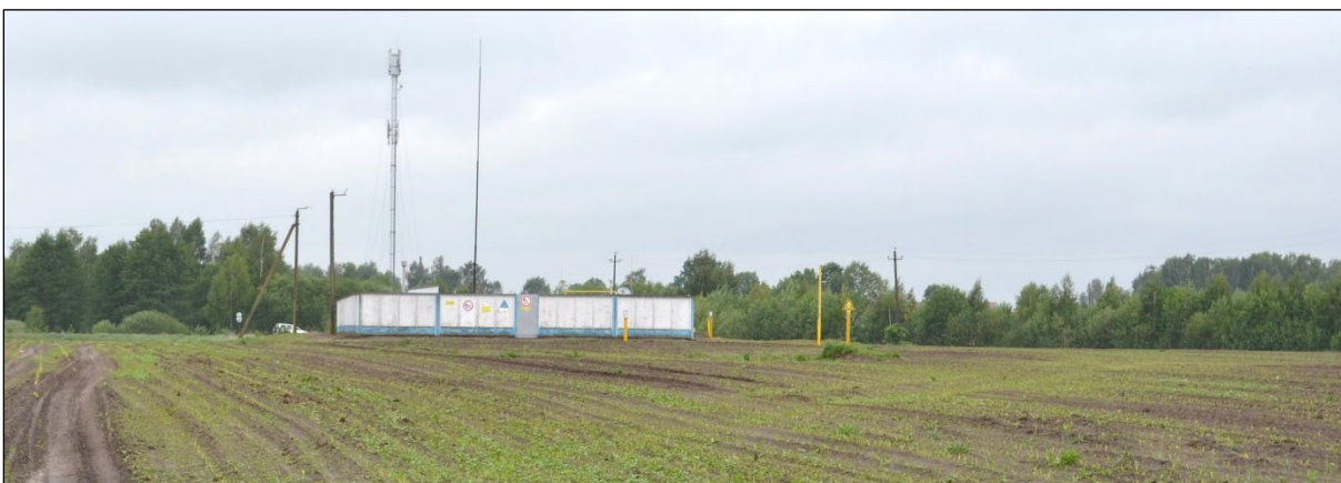
Рисунок 2.3 – ГРС «Здитово» (вид с севера)
